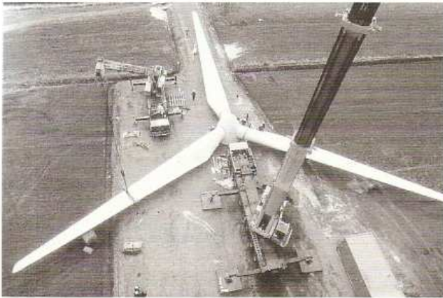
(d) Rotor der Tacke-1,5-Megawatt-Klasse vor der Montage
