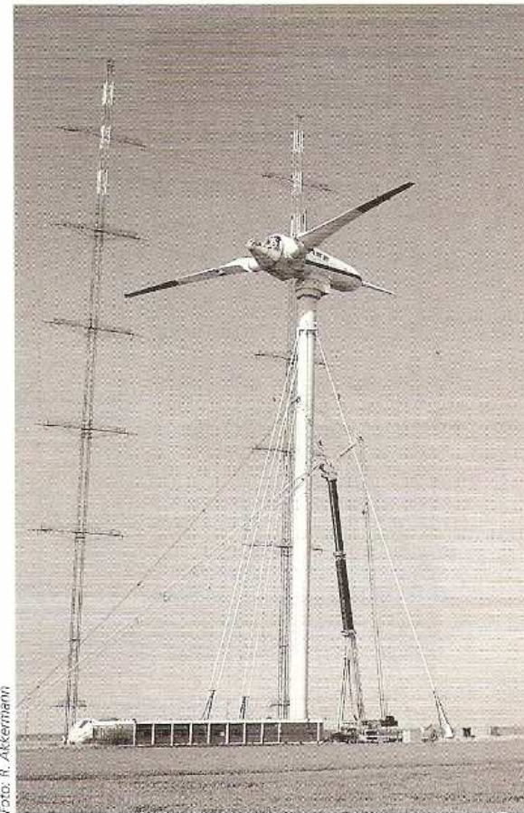
12. Die Großwindanlage GROWIAN bei der Demontage, eine Fehlkonstruktion von MAN im Auftrag der RWE. Links: Mast zur Messung der Windgeschwindigkeiten
