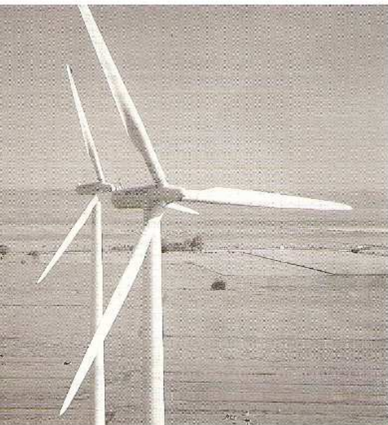
3. Windpark Bassens, Tele-Eindruck in Gondelhöhe, AN Bremen
